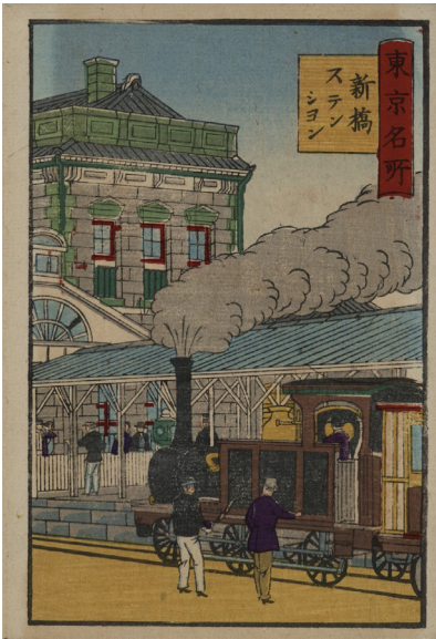
Рис. 9. Станция «Новый мост» (新橋ステーション)
