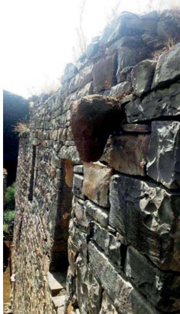
Рис. 9. Голова лошади в кладке стен нового дома в селении Яркуг, Агульский район, Республики Дагестан. Фото П. И. Тахнаевой
