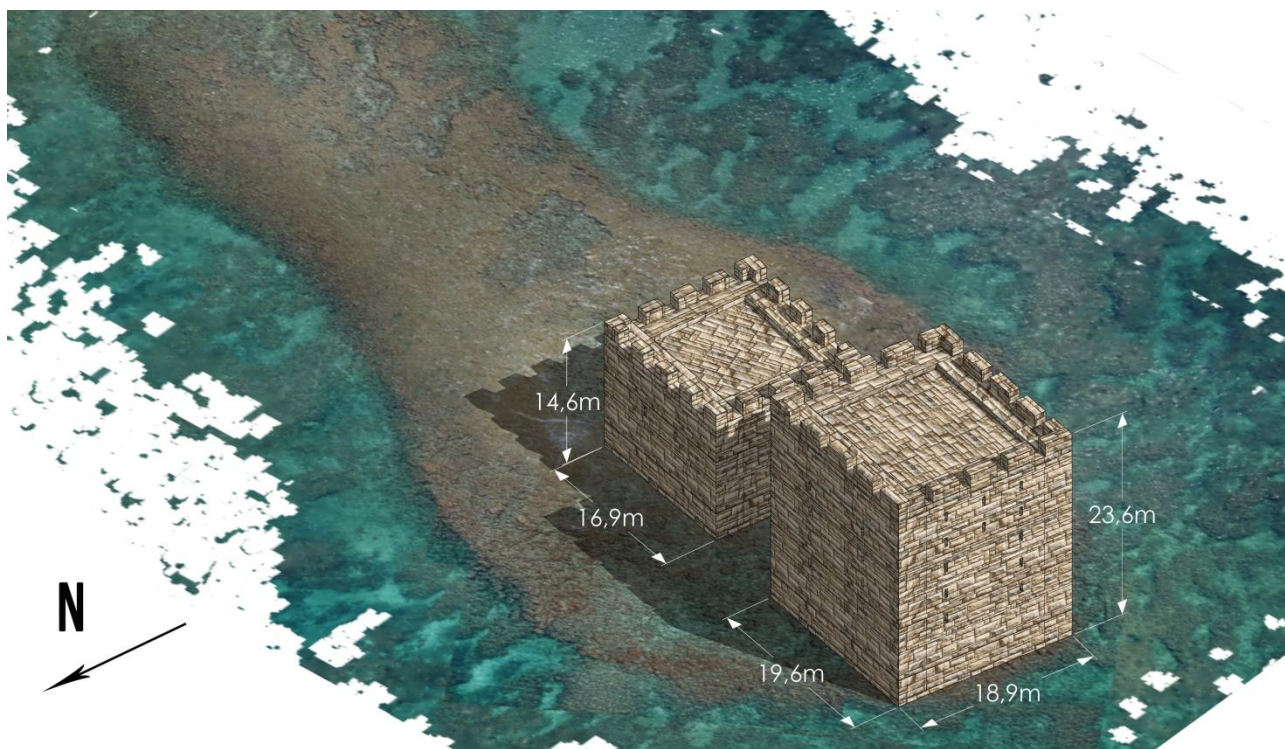
Ил. 5. Общий вид морского замка Мараклеи с северо-запада (выполнила А. А. Башенкова)
