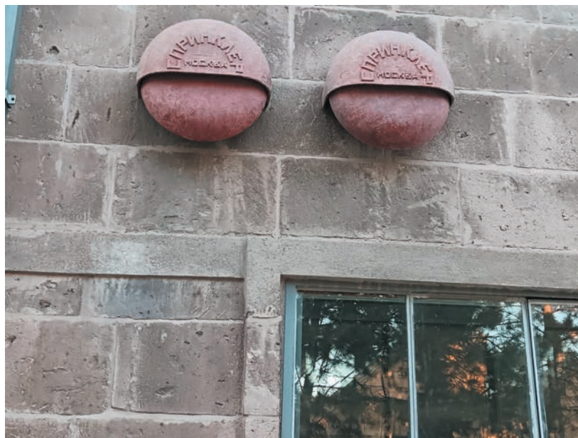
Рис. 6. Внешний вид здания фабрики с сохранением аутентичных элементов первоначального оформления — спринклеров для пожаротушения Источник: фотоархив автора
