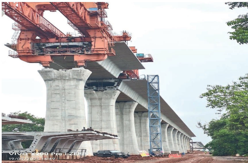
Рис. 3. Строительство эстакадной части ВСМ 1 участка Бангкок — Накхонратчасима Источник: https://www.highspeedrail-thai-china.com/wp-content/uploads/2025/10/2-3-300x194.jpg
