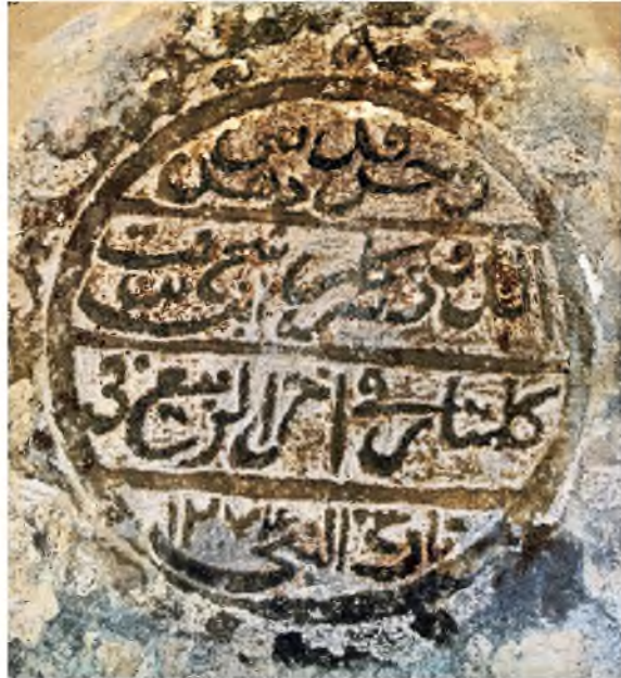
Рис. 5. Надпись 1858 г. о ремонте дома. Фото З. Ш. Закарияева
